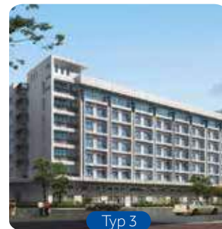
Niższe budynki wielkopowierzchniowe
